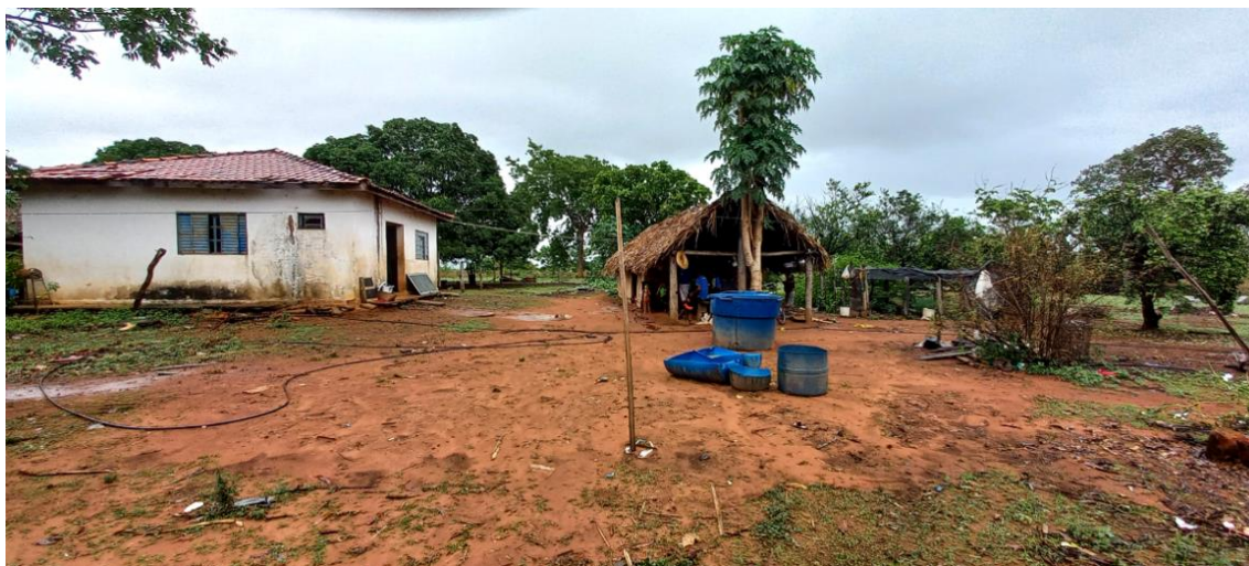
Infraestrutura de armazenagem de água domiciliar (Projeto de reassentamento Campestre)
